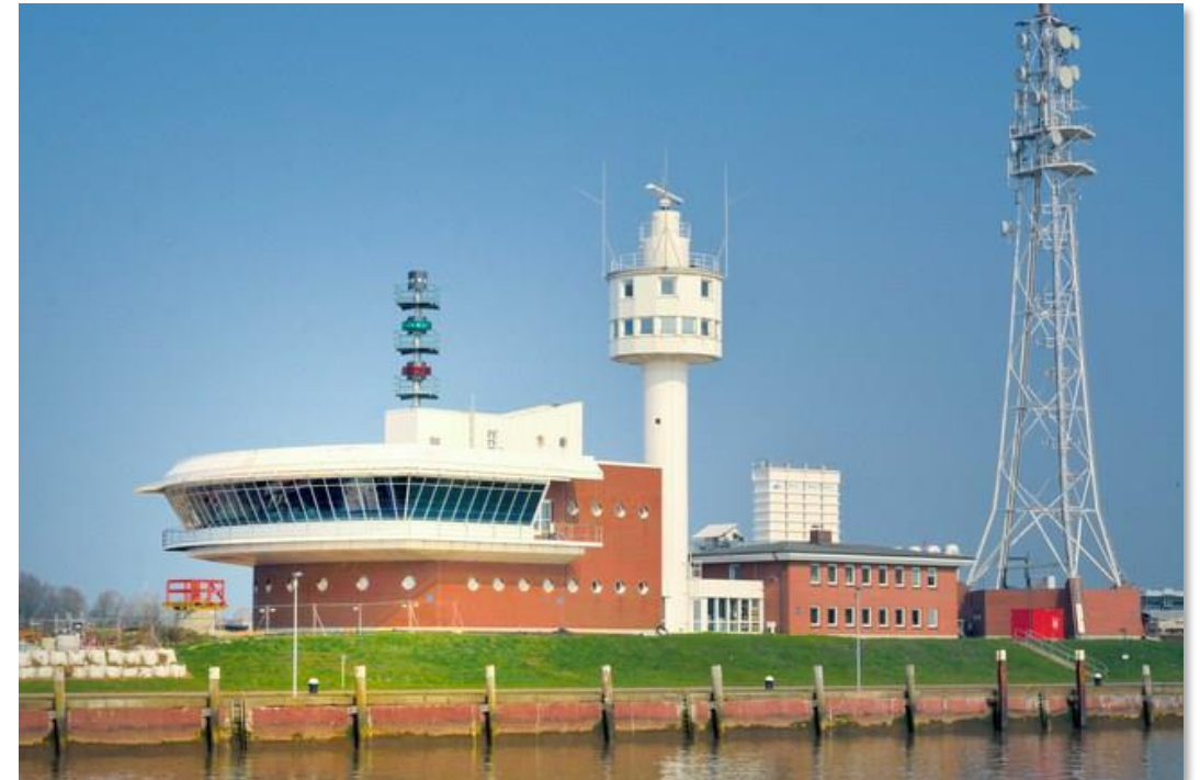
Verkehrszentrale Brunsbüttel [Quelle: https://www.gdws.wsv.bund.de ]
